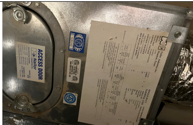
18. Typ VAV nameplate and access door
